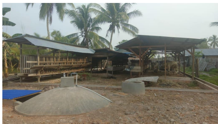
Gambar 4. Biodigester terintegrasi dengan kandang ternak
