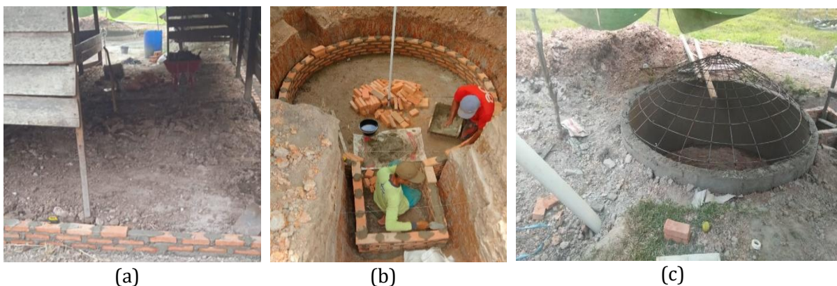
Gambar 3. Perkerasan lantai kandang (a) pembuatan lantai dasar dan dinding biodigester (b) dan (c) Tampak biodigester dari permukaan tanah
