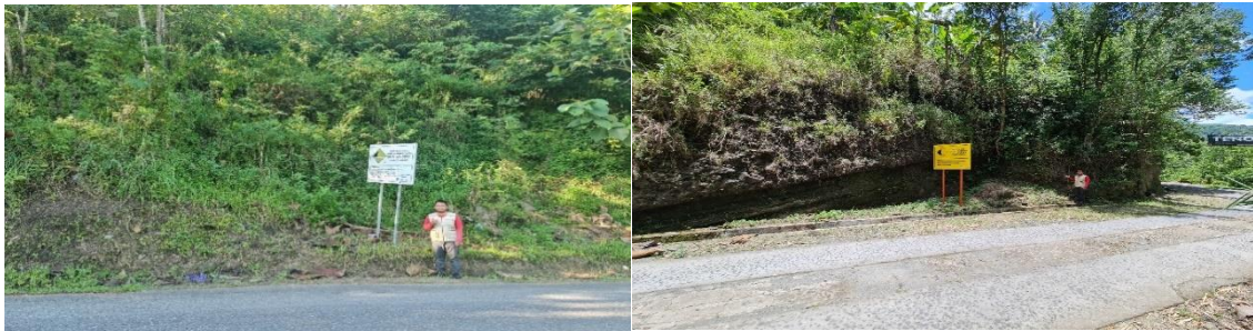
Gambar 1. Papan peringatan rawan longsor
