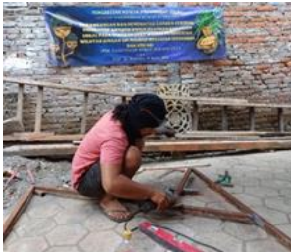
Gambar 4. Pembuatan konstruksi rakitan garden fertikal dari besi siku dengan teknik rakitan teknik las dengan melibatkan mitra program desa Petungsewu yang dibantu oleh desa mitra Petungsewu
