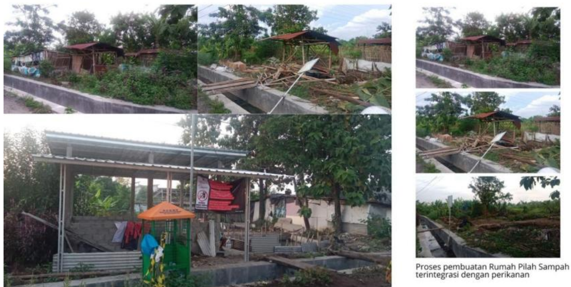
Gambar 2 Proses Pembangunan Bank Sampah Kering
