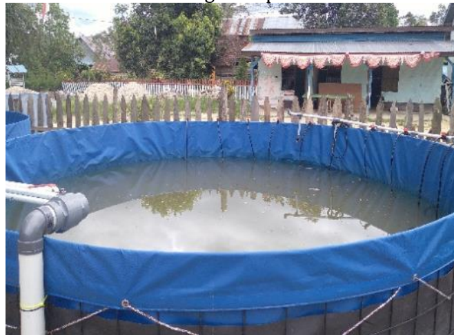
Gambar 2. Pemasangan terpal dan instalasi air
