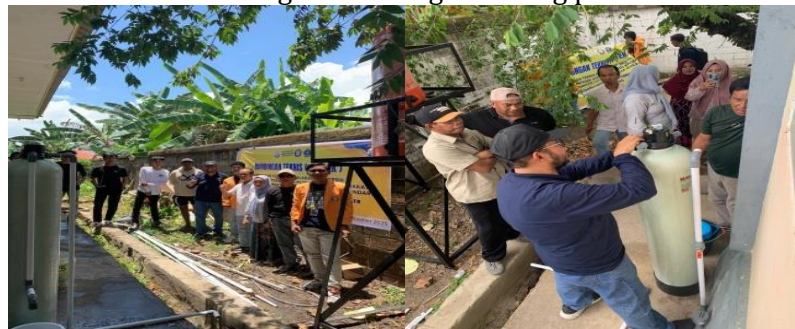
Gambar 5. Pemasangan aerator gelembung pada tandon air
