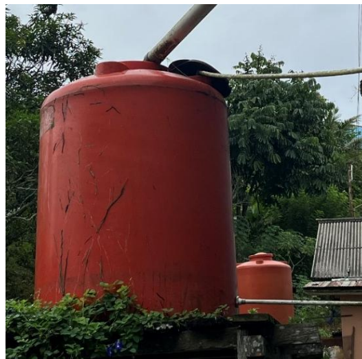
Gambar 4. Pemanenan air hujan oleh salah satu rumah di Kelurahan Tanah Merah
