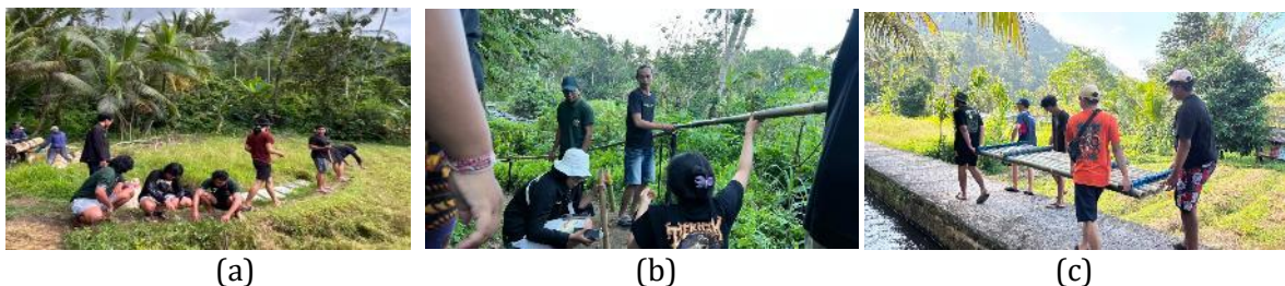
Gambar 4. Penataan aksesibilitas dan keamanan wisata di kawasan Pesiraman (a) penataan jalur setapak, (b) pemasangan handrail, dan (c) pembuatan jembatan bambu.
