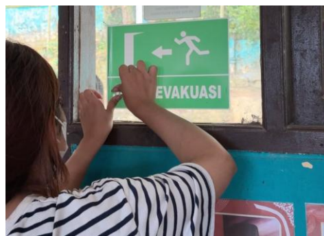
Gambar 1. Pemasangan Safety Sign
