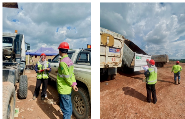
Gambar 4. Sidak Kelengkapan unit
