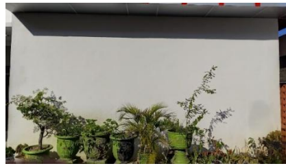
Gambar 1. Kondisi awal area EcoWall dan GreenCorner
