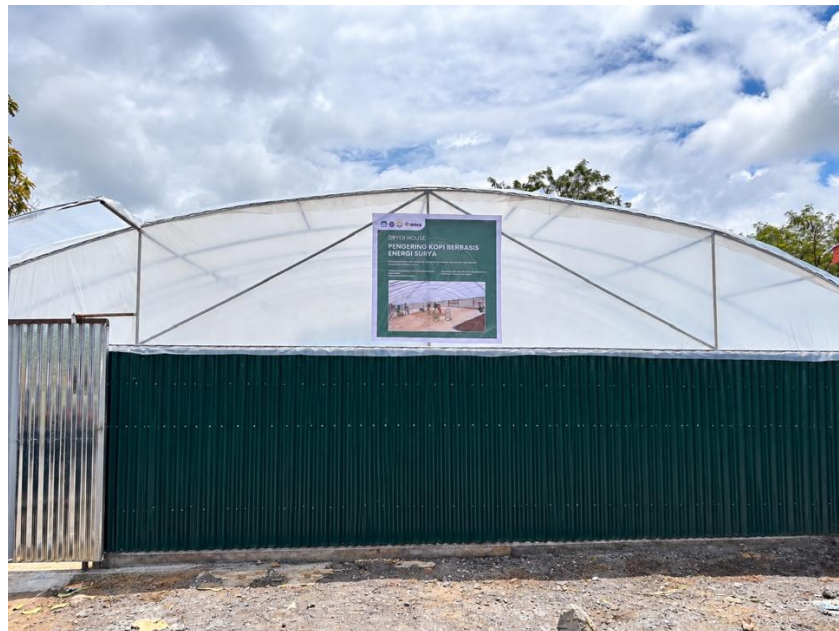
Gambar 2. Teknologi Pengering Kopi Berbasis Energi Surya Sumber: Dokumentasi Penulis (2026)
