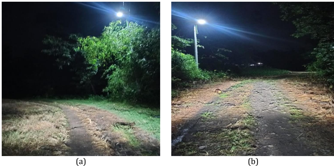
Gambar 5. Pemasangan Penerangan Jalan Umum Titik Pertama (a) dan Titik Kedua (b)
