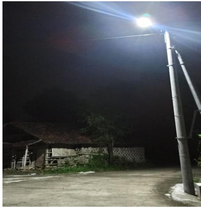
Gambar 7. Pemasangan Penerangan Jalan Umum Titik Kelima
