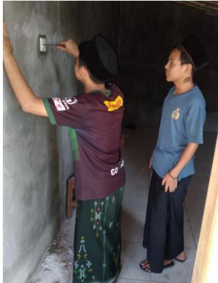
Gambar 5. Pengecekan hasil instalasi listrik dengan tespen
