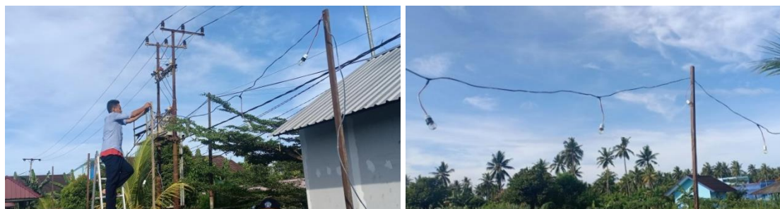
Gambar 7. Pemasangan Lampu Gantung
