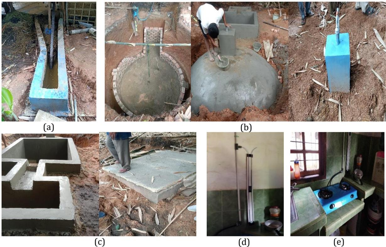
Gambar 6. Dokumentasi pembangunan instalasi biogas (a) Inlet (b) Digester (c) Outlet/slurry (d) Manometer (e) Kompor biogas
