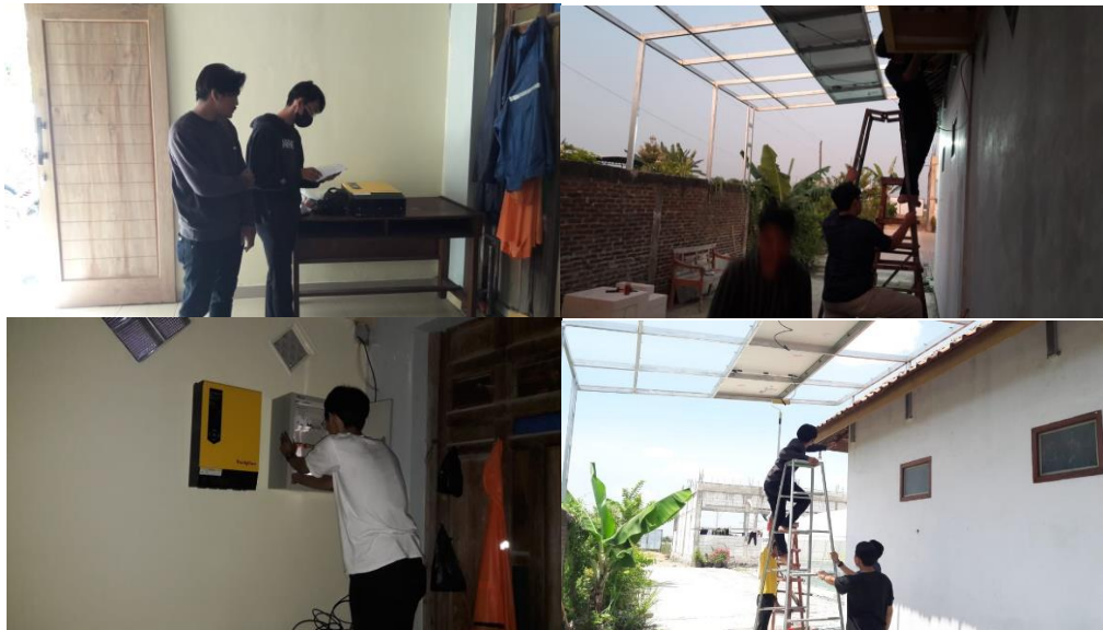
Gambar 9. Proses pemasangan PV
